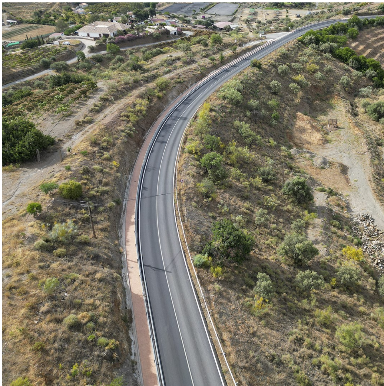
SENDA PEATONAL TRAMO DE CARRETERA DE BENAGALBÓN (MA-3200) COMPRENDIDO ENTRE EL P.K. 1+985 AL P.K. 3+005
